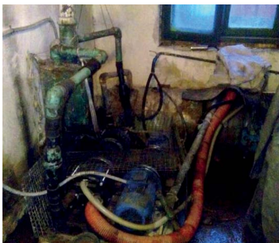
Рис. 5. Низкая производительность вакуумных насосов требует одновременной работы нескольких насосов, что приводит к дополнительным затратам
