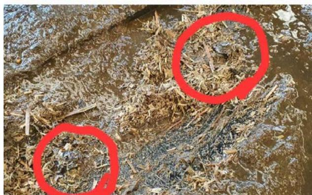
Рис. 7. Разрушенный пол с торчащими металлическими элементами — самая частая причина травмирования копытцев коров на ферме
