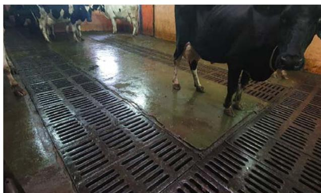
Рис. 3. Коровы между металлической решеткой и бетоном выбирают бетон
